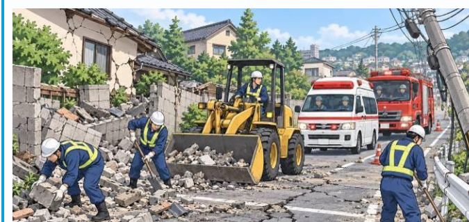
地震後の道路啓開イメージ
