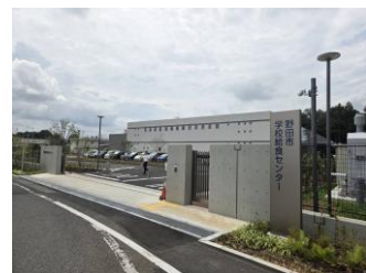
新しくなった野田市学校給食センターを視察しました
