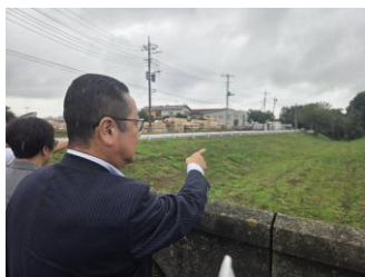
くりぼり川盛土状況を視察
