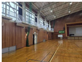
岩中学校体育館エアコン設置状況を視察
