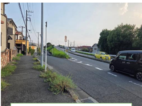
春日町の陸橋の修繕を要望しました
