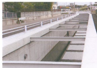
〈整備が進む六丁四反水路〉
