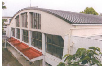
〈耐震化が完了した中央小体育館〉
