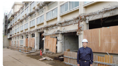
▲小中学校の耐震化工事の現地を視察しました
