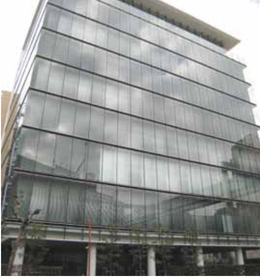
↑「千葉県市町村総合事務組合」が入居する千葉市中央区のビル。
