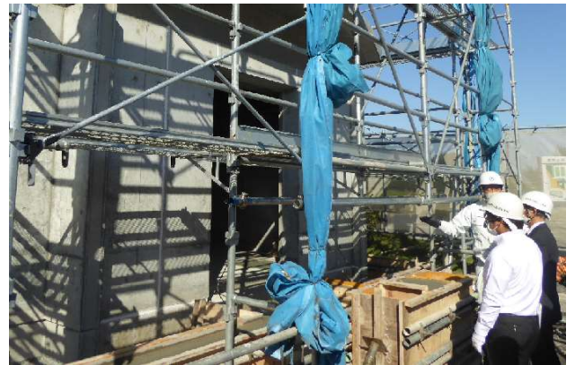
建設中の合葬墓を視察
