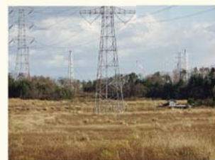
福島第一原子力発電所
